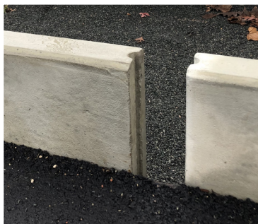
Smalt inlopp med raka kanter. Risk för att dagvattnet finner vägar förbi regnbädden.
