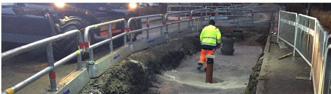
Utläggning av dränerande bottenlager.
