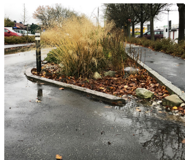
Regnbädd med fall och inlopp för vattnet.
